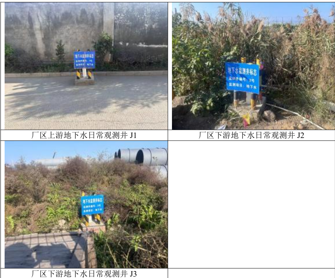
图 2.3-14 地下水监控井现场照片
