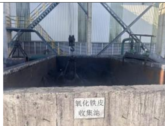
铁皮池沉淀污泥
